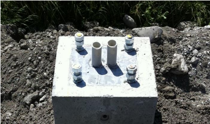
Abb. 1) Vorbereitete Sockelfundamente
